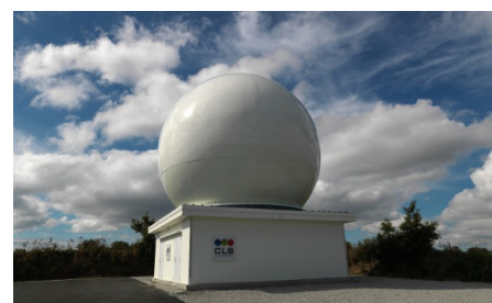
Station de réception directe et d'analyse d'images satellites radar haute résolution VIGISAT
